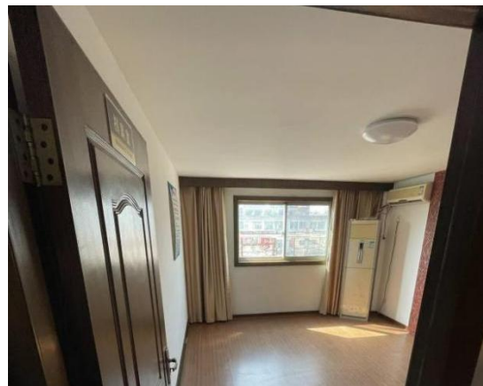
探伤机贮存室南侧
