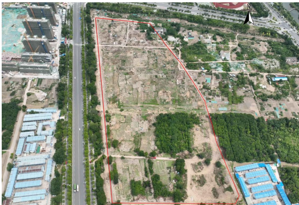
图 3-4 地块现状航拍图（2022 年 6 月 14 日）
