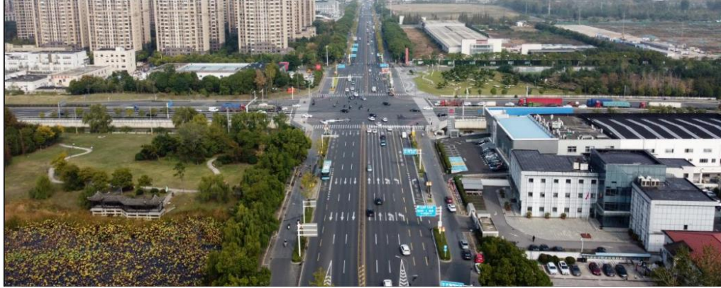
图 3-2 扬子江路与 328 国道交叉口现状图-1
