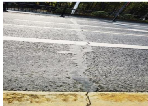
图 3-5 道路裂缝养护
