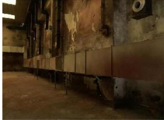
涂装废气收集装置
