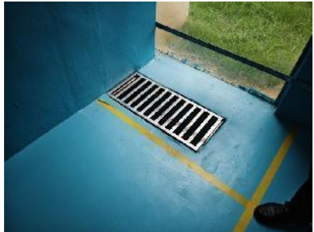
危险废物暂存库
