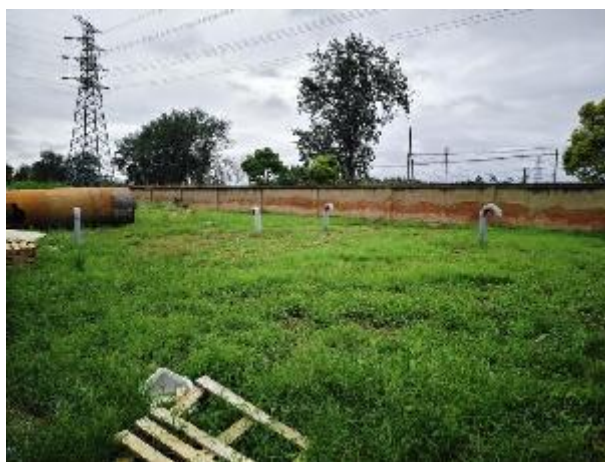
园区应急事故池
